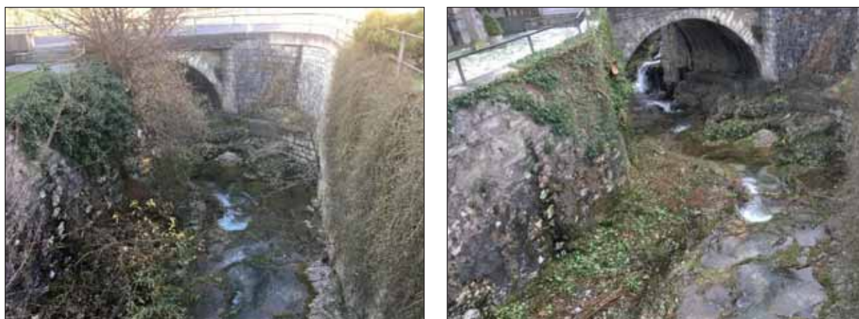
Figura 3 – Tratto terminale dell'area d'intervento: prima (a sinistra) e dopo (a destra) gli interventi.
