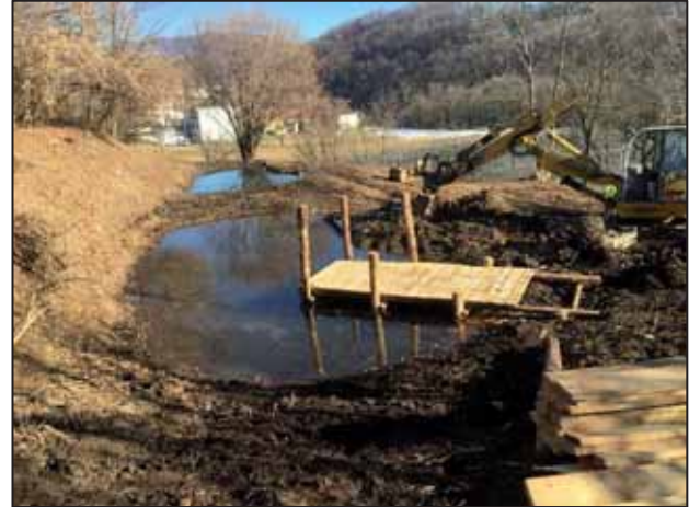
Figura 9 – Realizzazione piattaforma di osservazione.
