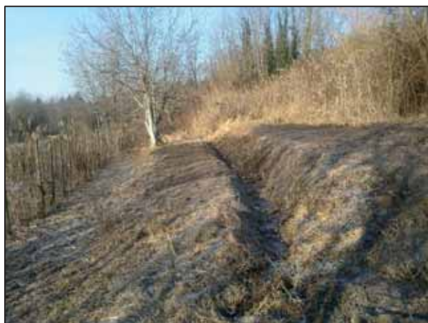
Figura 18 – Canale di drenaggio a monte del vigneto.
