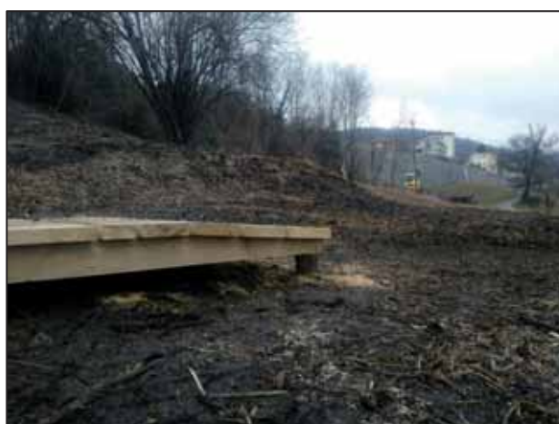
Figura 17 – Dettaglio imbocco sentiero su passerella.
