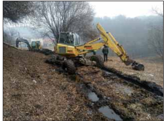
Figura 5 – Scavo degli stagni mediante ragno.
