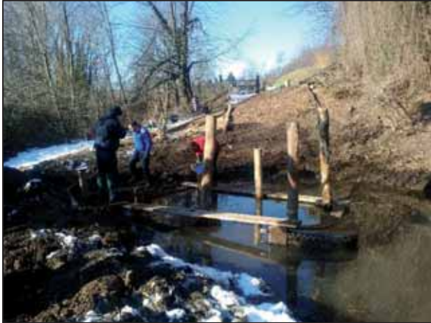
Figura 8 – Realizzazione piattaforma di osservazione.
