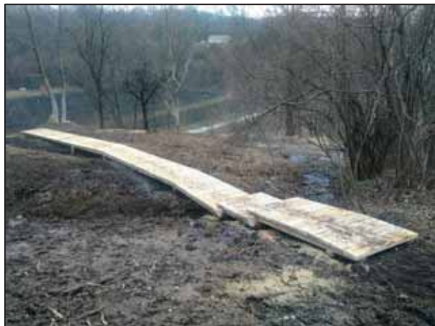
Figura 14 – Passerella finita da monte.
