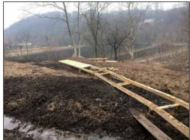
Figura 11 – Realizzazione sentiero su passerella.
