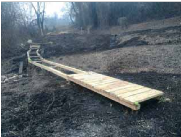
Figura 12 – Realizzazione sentiero su passerella.
