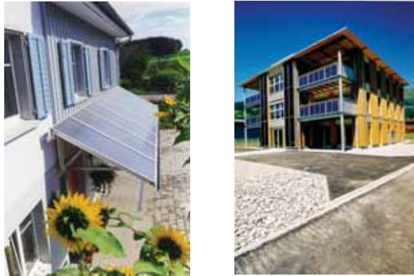
Figura 4: A sinistra, 14.4 m 2 di collettori solari integrati in facciata [SSES, Autore: Heizplan AG, 9450 Altstätten]. A destra, 61 m 2 di collettori solari integrati in facciata [SSES, Autore: Schibli Peter, Heizplan AG, 9473 Gams].
