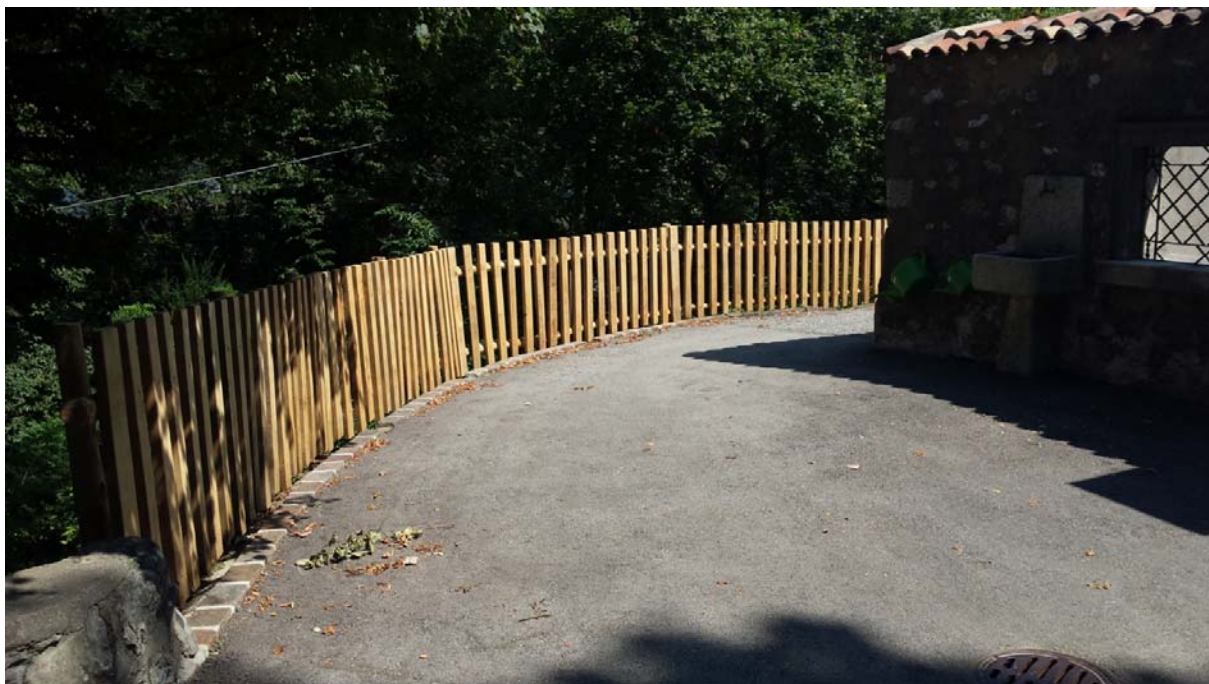
Palizzata di sicurezza
