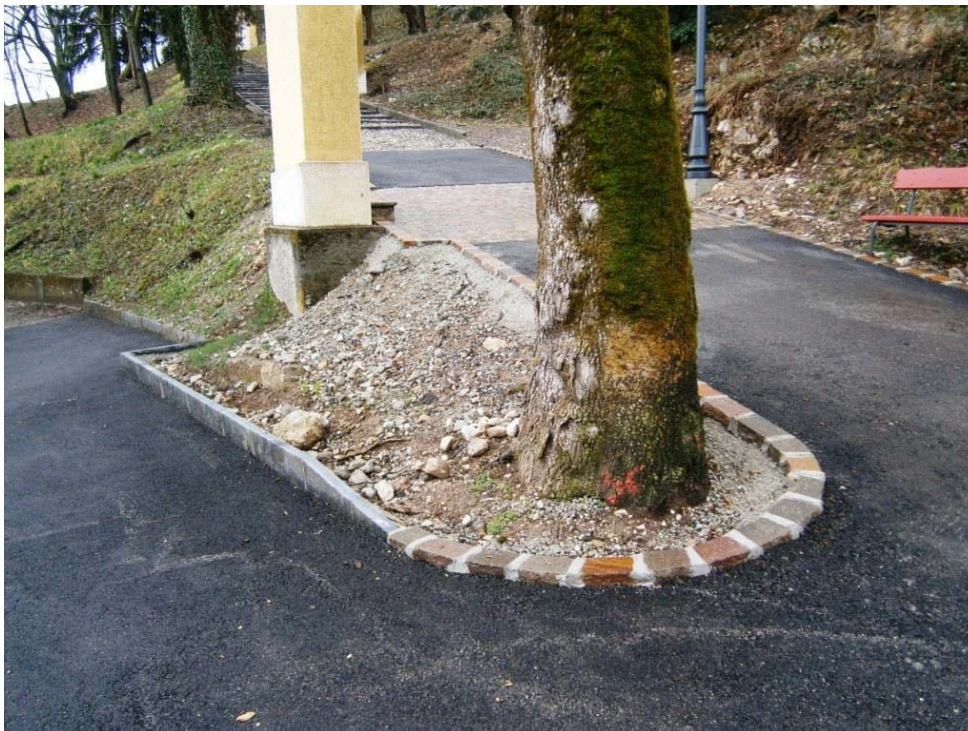
Prima dei lavori
