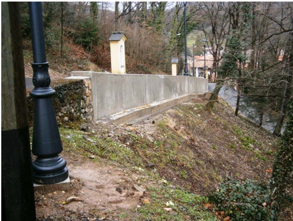
Prima dei lavori
