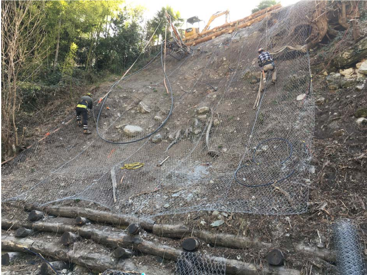
Figura 5: perforazioni e ancoraggio della rete; in alto s'intravede la palificata di legno a sostegno del ciglio (marzo 2017).
