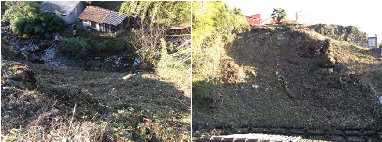
Figure 3/4: pendio pulito dalla vegetazione e dai sassi instabili (febbraio 2017).
