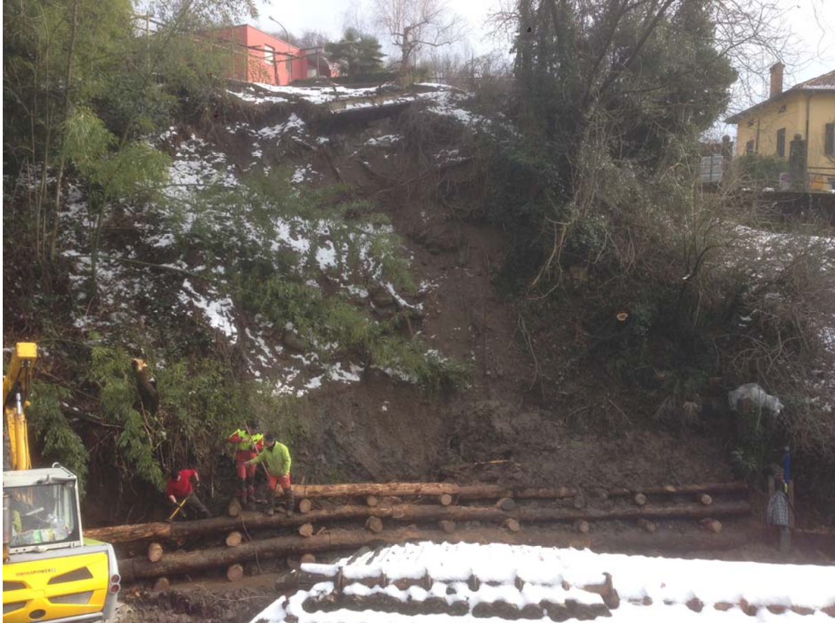
Figura 2: pendio in oggetto, durante i primi lavori di consolidamento dell'argine (febbraio 2015).
