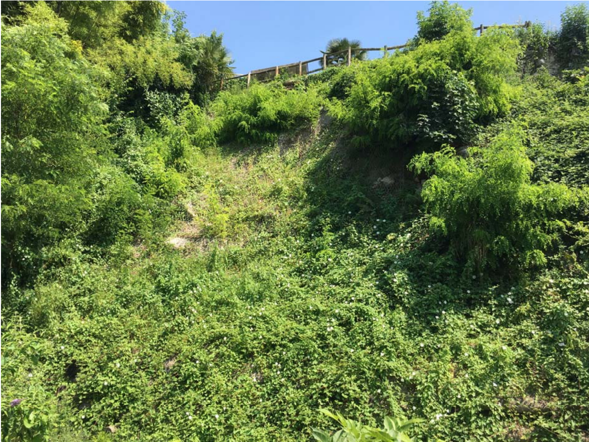
Figura 6: rinverdimento a lavori terminati (giugno 2017).
