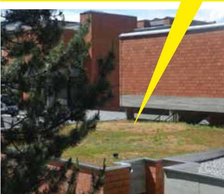
Il tetto inverdito (estensivo) del Centro scolastico Canavee
